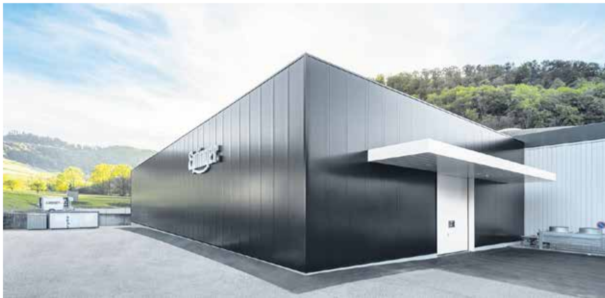
Die im vergangenen April in Betrieb genommene Lagerhalle hat Platz für 1200 Paletten.
